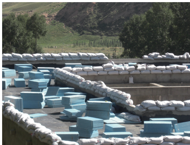
图 2-11 陈列馆防水工程施工 来源：案例地提供
